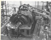
Appontamento per la prova della turbina di bassa pressione
