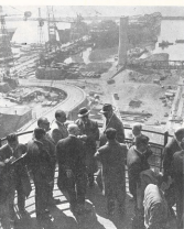
Sesta al Cantiere di Sestri, dopo la visita al Mecanico, di una missione iraniana ospitata recentemente dall'Ansaldo
