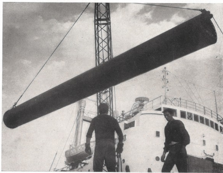
Imbarco dei tubi "tarantini" destinati al grande gasdotto argentino.
