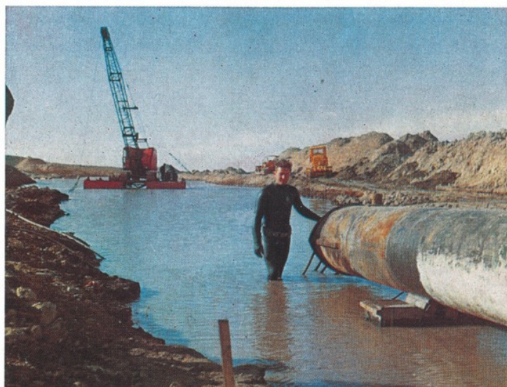
Il difficile lavoro di sistemazione delle tubazioni in una zona fluviale.
