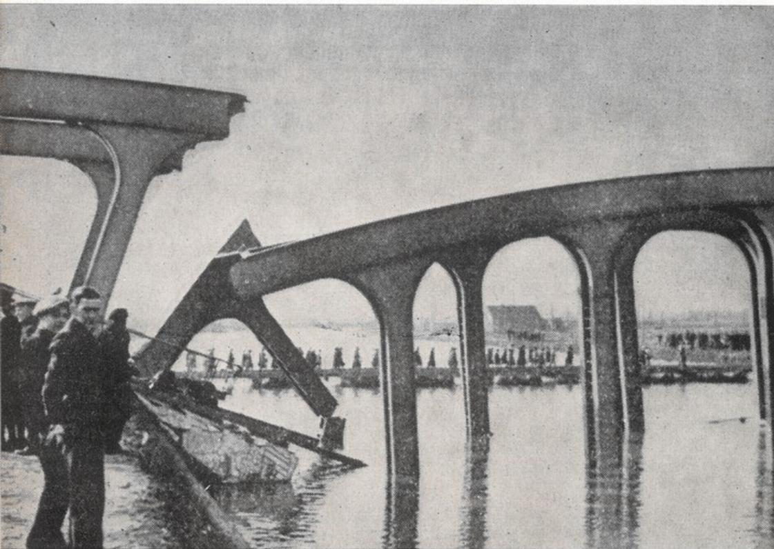
Veduta del ponte Hasselt in Belgio, dopo la rottura "fragile" avvenuta nel marzo 1938 (da "La fragilità dell'acciaio" - M. Szezepanski, Londra).
